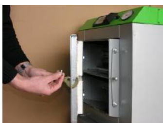
Fot.10. Po odwróceniu zamontować uchwyt zaciskowy.
